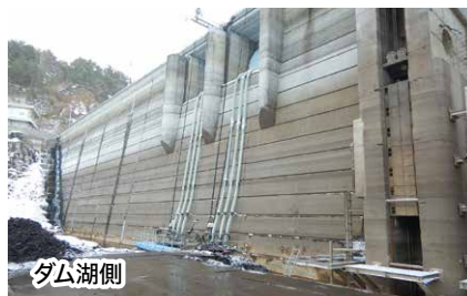
排水ポンプによる強制排水の状況
