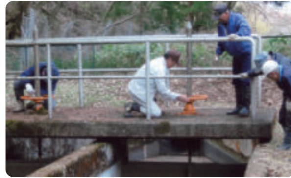
水門の開け閉め作業
