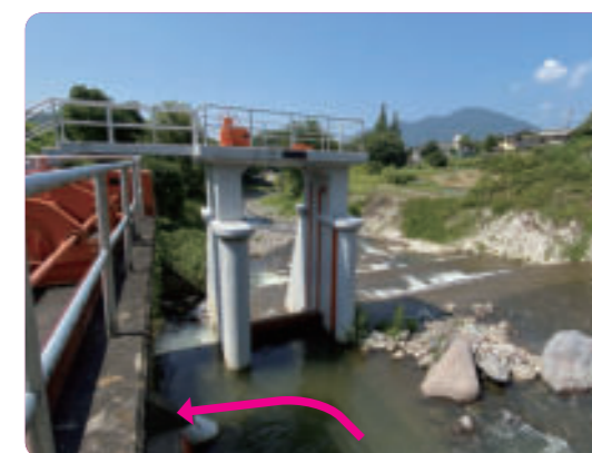
頭首工の裏側、矢印の方に取水口があって、そこから水を取り入れます。
