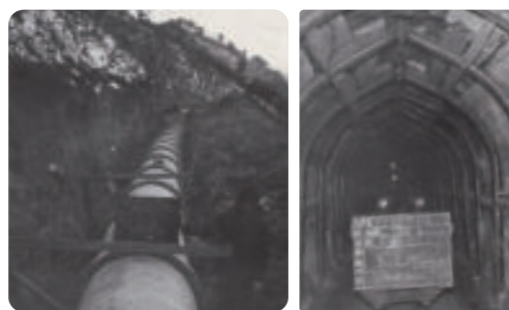
パイプやトンネルを作った時の写真
