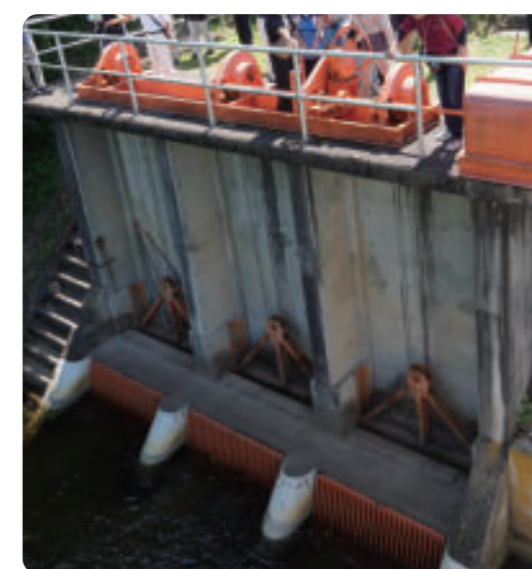
これが取水口です。上部のハンドルを回して、ゲートを開けて川の水を取り入れます。
