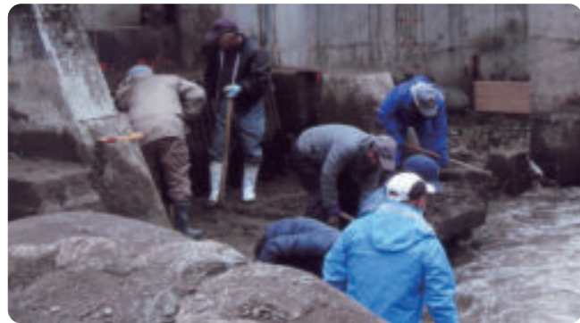
台風などで川底にたまった土砂を取り除く作業
