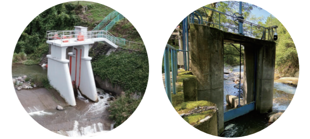
頭首工(水をせき止める)
