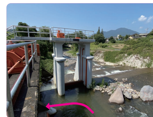
うらがわ しゅすいこう 頭首工の裏側、矢印の方に取水口があって、そこから水を取り入れます。
