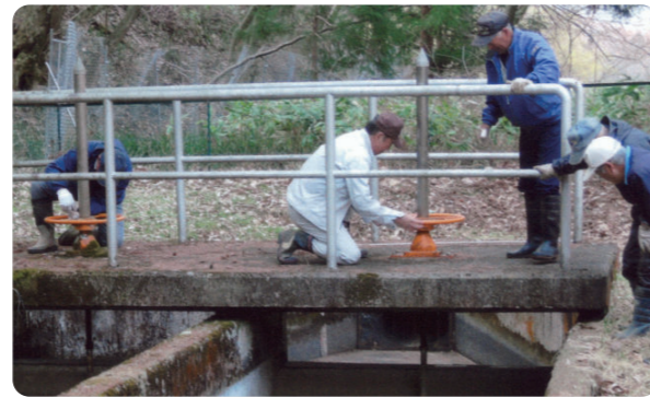
水門の開け閉め作業
