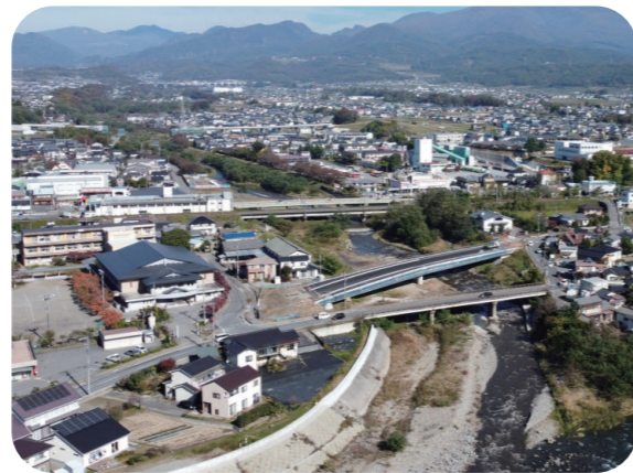
神川に架かる国道18号、しなの鉄道、神川橋
