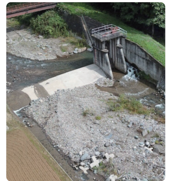
左岸幹線水路の頭首工です。中島堰はここから水を取り入れています。
