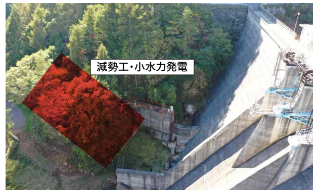
③:減勢工の更新・小水力発電設備の設置(R5完了予定) 減勢工を更新し、小水力発電設備を新たに設置します。
