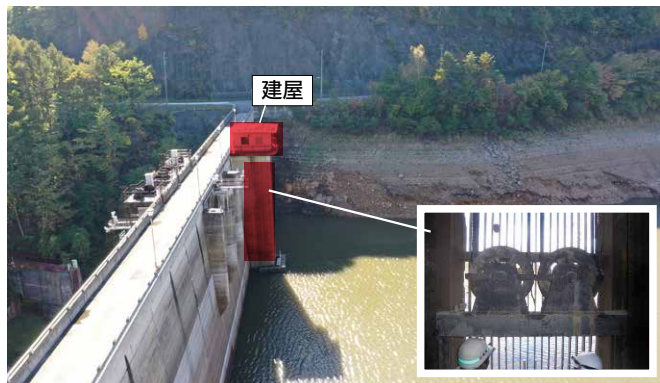
②:取水設備ゲートの更新・建屋更新(R5完了予定) 耐用年数を超過した施設を新しくします。
