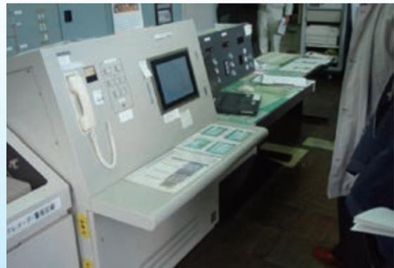
ダム管理棟内の電気関係機器類は、一般的な製品寿命（耐用年数）を超過しているものもあります。
